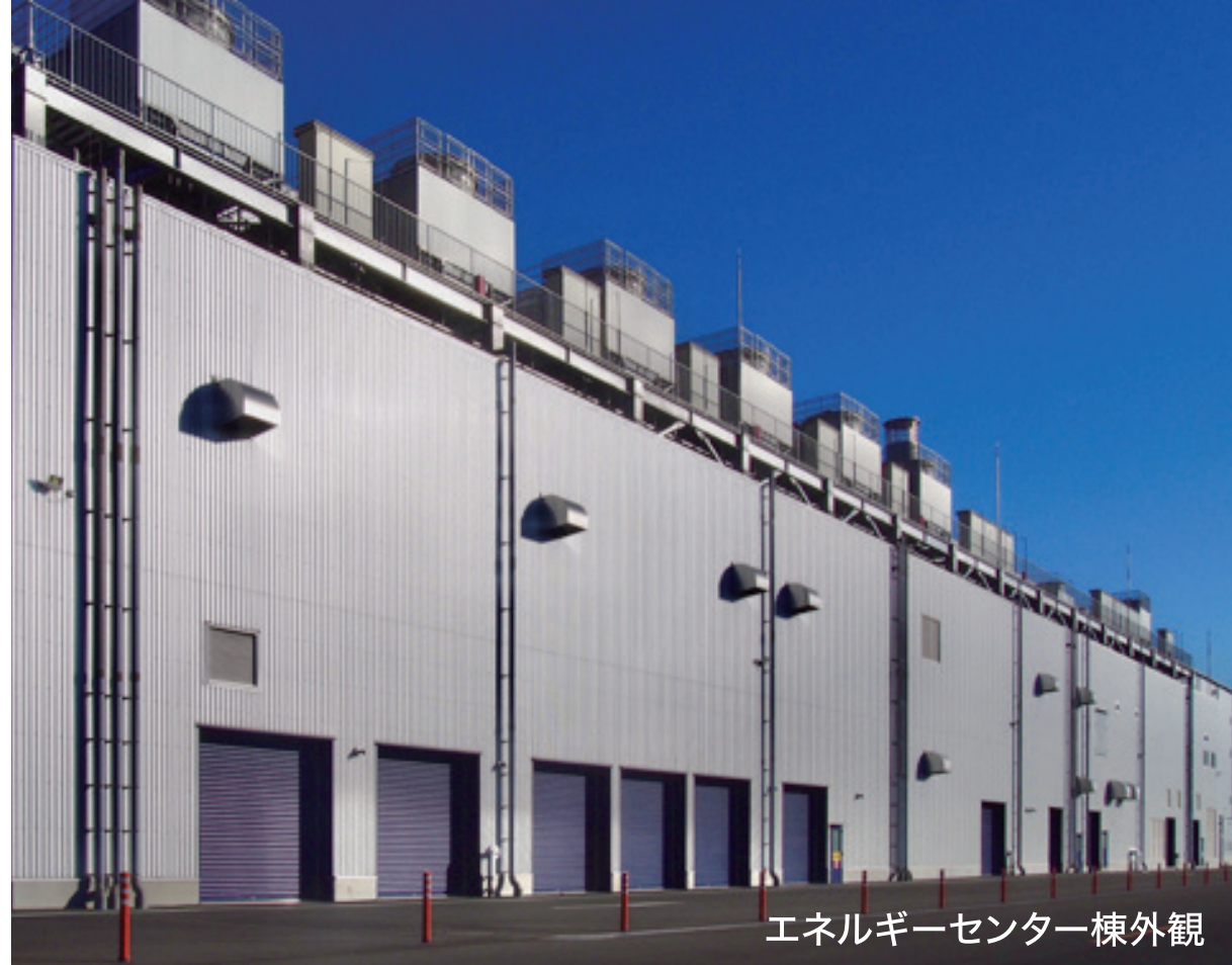
エネルギーセンター棟外観
