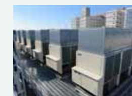
高効率空冷ヒートポンプチャラー (エネルギー棟屋上)
