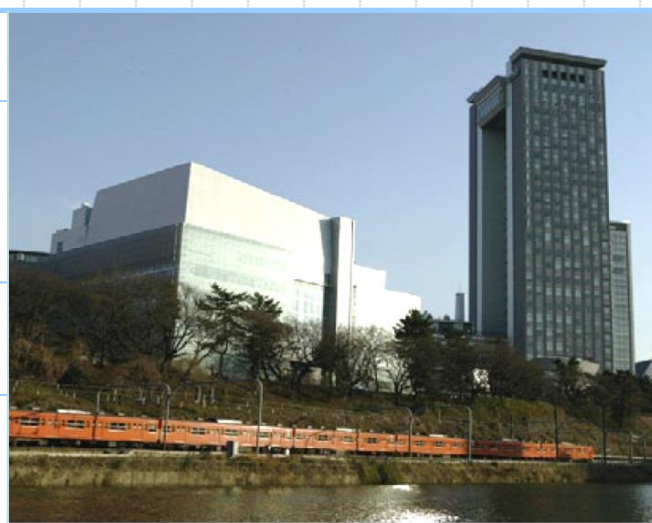
法政大学 外堀校舎
