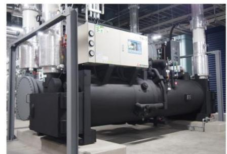
● 熱回収ターボ冷凍機
