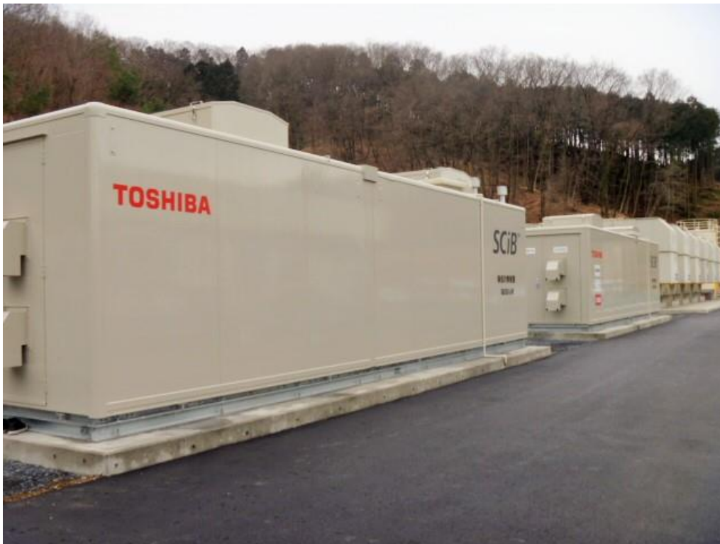
<スバル研究実験センターに設置されたリチウムイオン蓄電池等>
