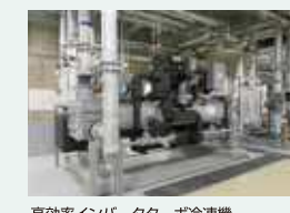
高効率インバータターボ冷凍機
