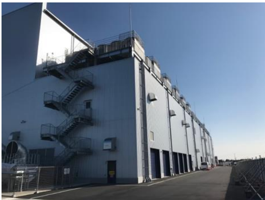
排熱回収システムを導入したエネルギーセンター棟外観 (写真建物右側)
