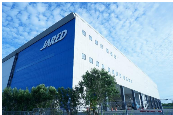
太陽光発電設備を設置する JARED 大井川センター
