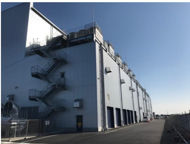
エネルギーセンター棟外観 (写真建物右側)
